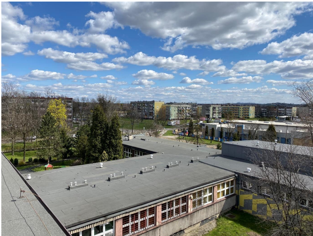
-przewody wentylacji grawitacyjnej na dachu
