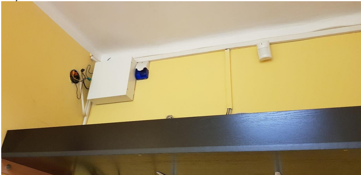
Zdj.10. Widok centrali alarmowej w pom. kierownika gosp. na parterze.
