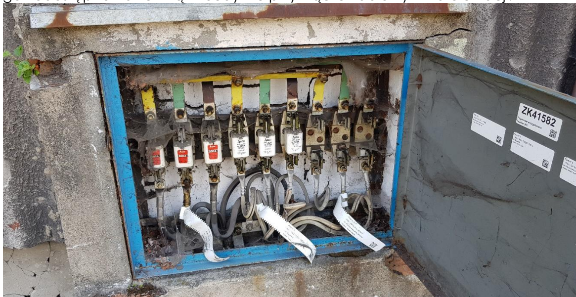
Zdj.1. Widok złącza kablowego
