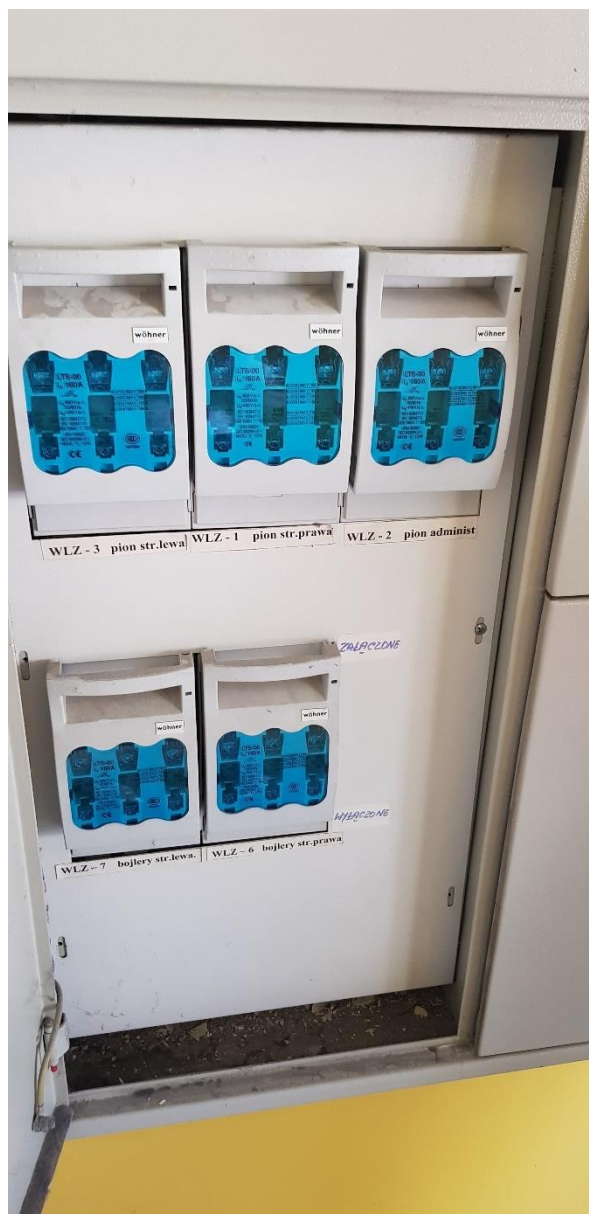
Zdj.3. Widok rozdzielnicy głównej – WLZ-ty.
