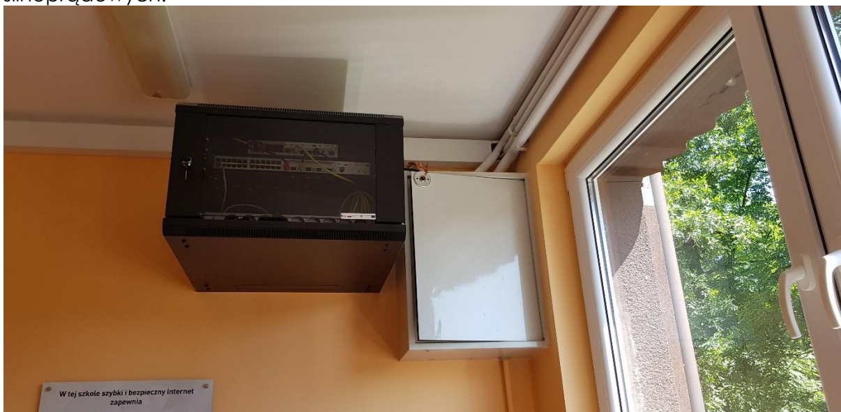
Zdj.9. Widok szafy RACK oraz szafy z światłowodem.
